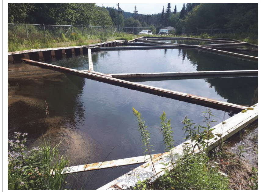
Photo 1 : Les trois bassins de décantation – 2019-08-07
