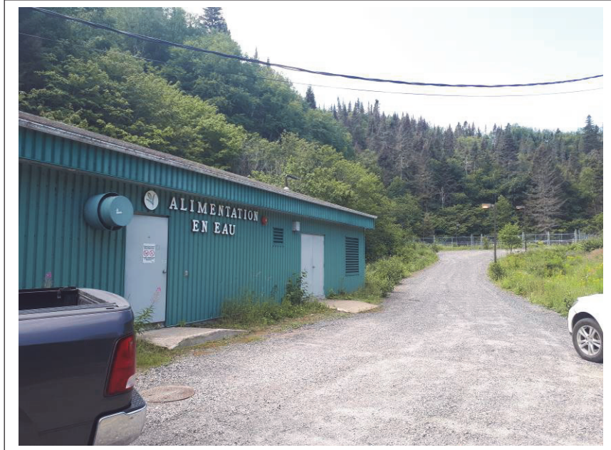
Photo 7 : Station de pompage - 2019-08-07
